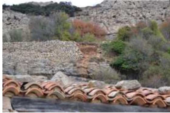
Imatge 6-7: l'aigua mal drenada dels bancals erms acaba essent uns dels pitjors enemics dels murs de pedra seca.
