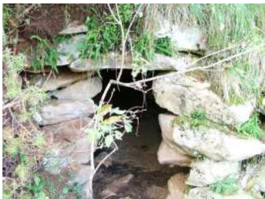
BARRACA DE L'ALEIX O DEL GATELL: És de dimensions mitjanes i secció circular. Es troba en força bon estat i té un gatell a tocar de la porta.
