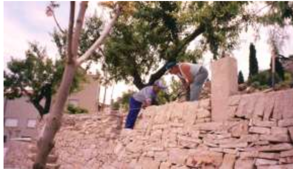
Fig. 10. Margenadors paredant al Camí cementeri . Fotografia, Joaquin Segarra (2003)
