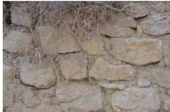
Imatge 9: mur de pedra seca amb una capacitat de drenatge limitada al estar saturat els espais entre-pedres per terra. En cas de terres amb alt contingut d'argiles expansives, juntament amb pluges intenses ocasionen que les murs es vagin unflant (les pedres van sent empentades cap a l'exterior) poc a poc al llarg dels anys fins al col·lapse del mur.
