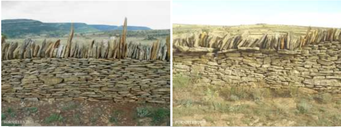
Fotografies 21 i 22. Esquerra, coronació amb pedres de dimensions variades. Dreta, mur amb pedrís i coronació vertical.
