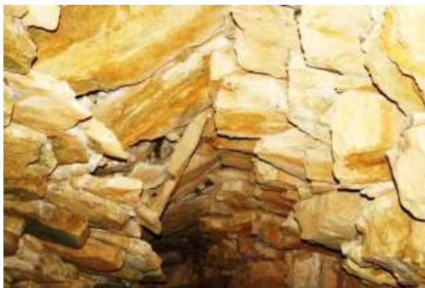
Fig. 3 Barraca de coberta de lloses de pedra i reble. Partida Barranc la Torn-Mas d'En Ramon
