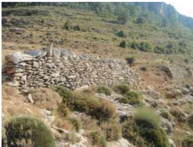
Fig 7. Muro de piedra destrozado por el paso del tiempo, sin embargo la huella que deja poco a poco se va recuperando, volviendo a su imagen primitiva
