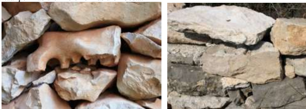
Fig. 1 Tipologia de pedra. Pedra foradada (esq.). Calcària i “mortina” (dreta).
