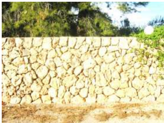
Marge recent que ensenya la vigència constructiva de la pedra en sec
