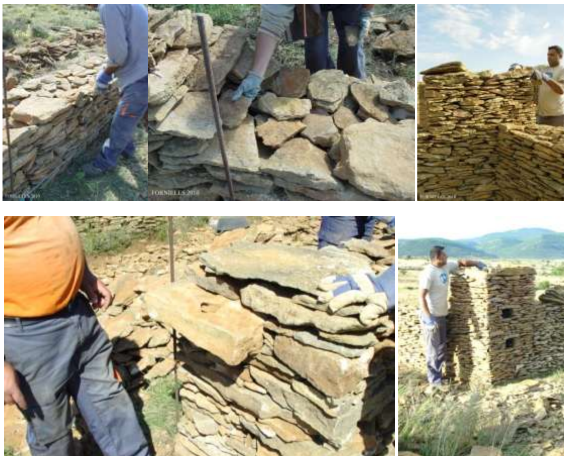
Fotografies 14, 15, 16, 17 i 18: Construcció del mur, cantons i portes.
