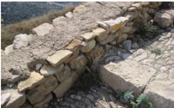
Fig 8 y 9. Muros de piedra realizados con cemento para unir la piedra. En los dos se observa como en el cemento queda visto, y como el terminado está peor acabado que lo que suele ser habitual en los muros de piedra en seco.
