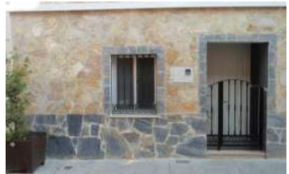
Fig 12 y 13. Mobiliario urbano y fachada de vivienda con acabado de chapado de piedra. En el mobiliario urbano se puede apreciar en la esquina que ha sufrido un desconchamiento, en Villalonga (Valencia)
