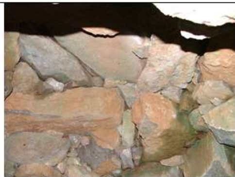
Detall des de dins del sostre on es veuen les lloses que tanquen la cúpula.
