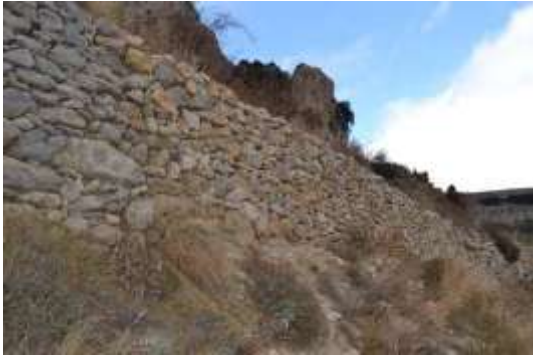
Imatge 4: Mur contra-terrer de pedra seca reconstruït per segona volta (la primera volta va durar 30 dies en peu).
