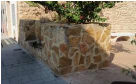
Fig 12 y 13. Mobiliario urbano y fachada de vivienda con acabado de chapado de piedra. En el mobiliario urbano se puede apreciar en la esquina que ha sufrido un desconchamiento, en Villalonga (Valencia)
