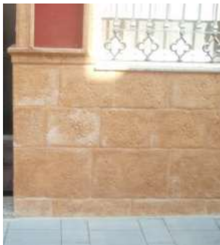
Fig 12 y 13. Mobiliario urbano y fachada de vivienda con acabado de chapado de piedra. En el mobiliario urbano se puede apreciar en la esquina que ha sufrido un desconchamiento, en Villalonga (Valencia)
