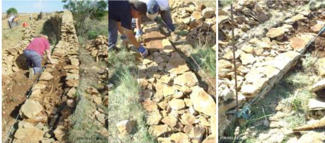
Fotografies 3, 4, 5, 6 i 7. Realització de la base del mur.
