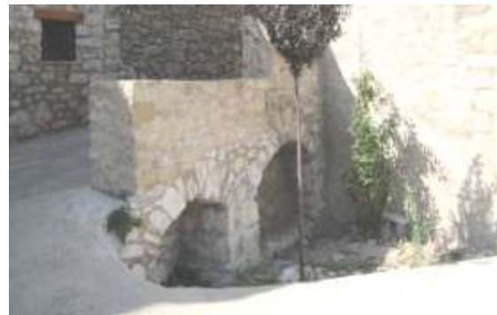
Fig 8 y 9. Muros de piedra realizados con cemento para unir la piedra. En los dos se observa como en el cemento queda visto, y como el terminado está peor acabado que lo que suele ser habitual en los muros de piedra en seco.
