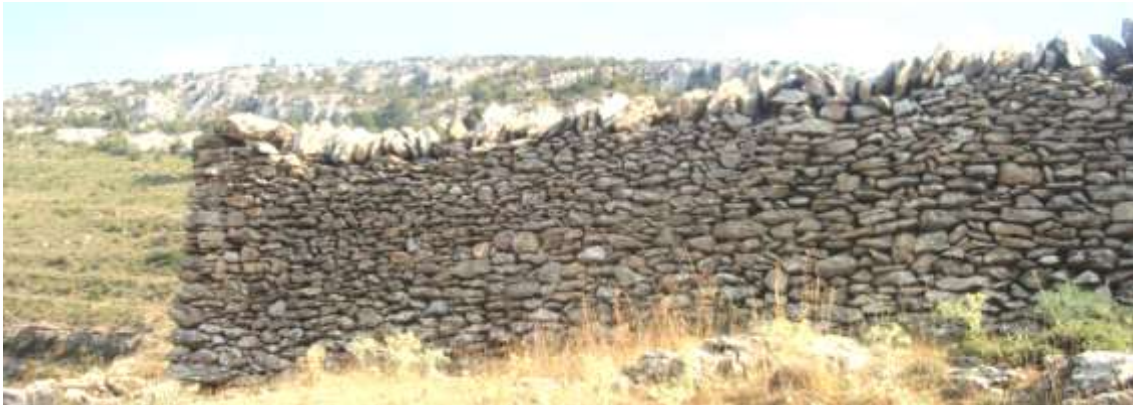
Fig 17. Muro de piedra en seco
