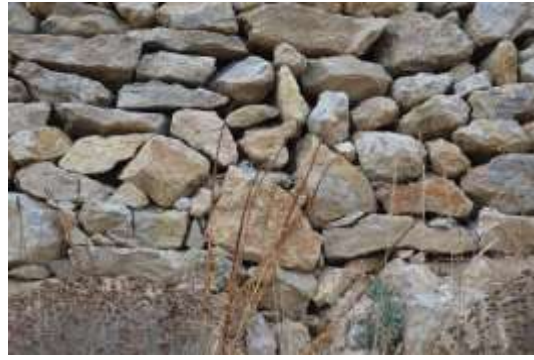
Imatge 5: detall del mur anterior on s'observa el formigó utilitzat pels constructors (no podent anomenar-los paredadors) davant la falta de confiança que es mantingui en peu. Tristament, aquest mur ha sigut subvencionat per l'administració pública igual que si l'hagués realitzat un especialista, per falta de criteri.
