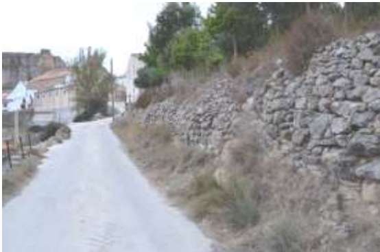
Imatge 8: excel·lent exemple de la gran capacitat de deformabilitat que pot adquirir un mur de pedra seca.
