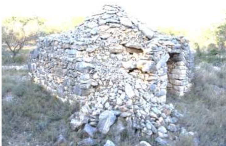
Fig. 15. Barraca de pedra en sec i efectes de solsidea per abandonament. Partida la Quixala
